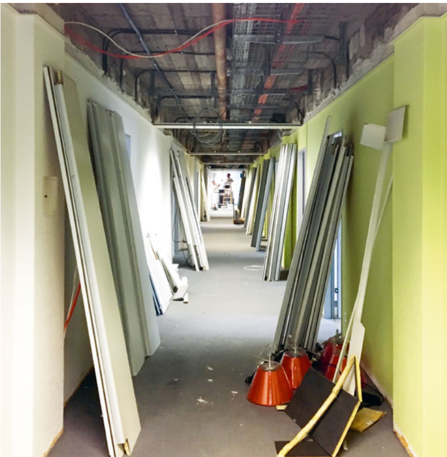
Umbaubeginn der zweiten Etappe.
